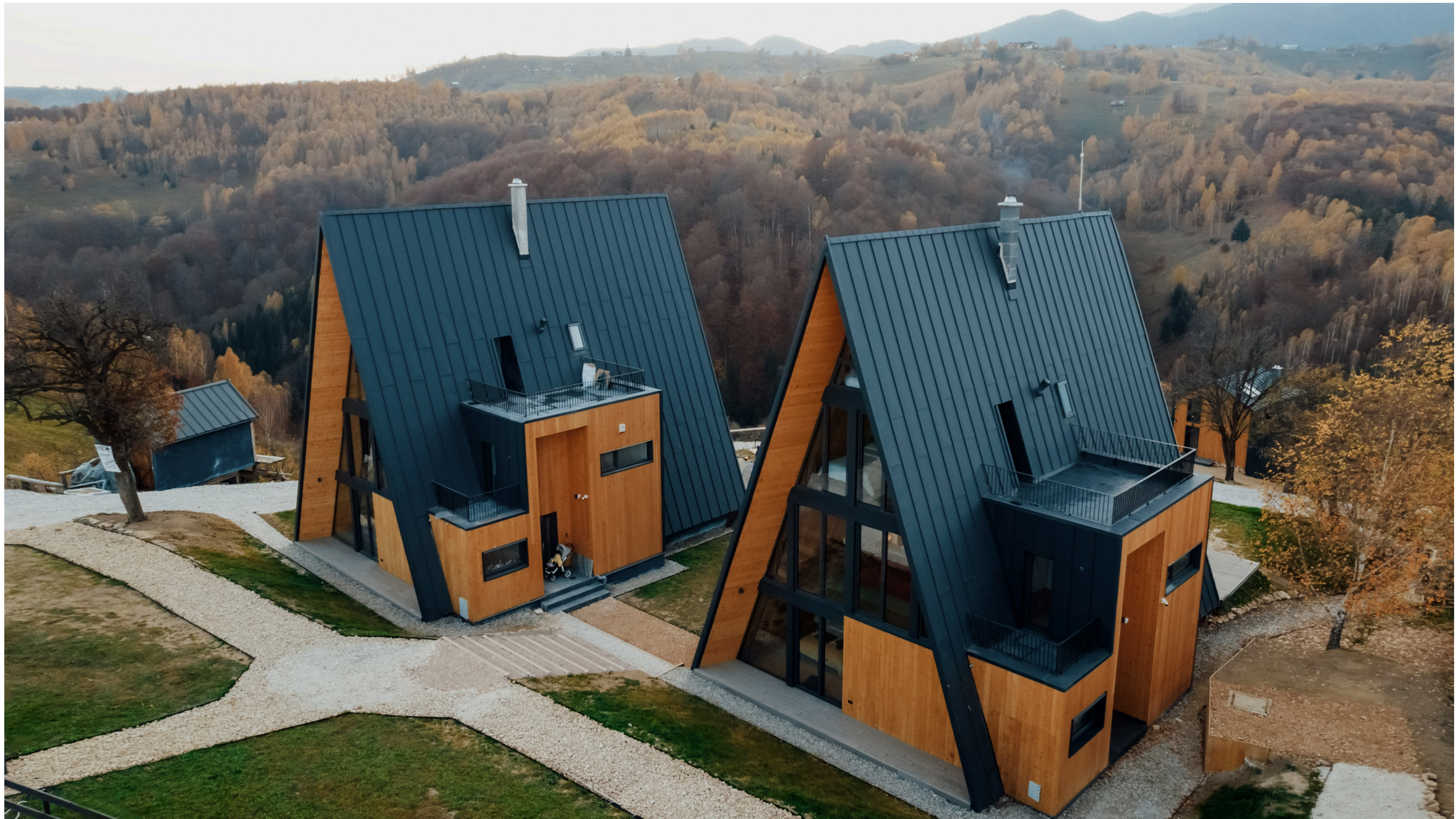
Amont Chalet Peștera, România
